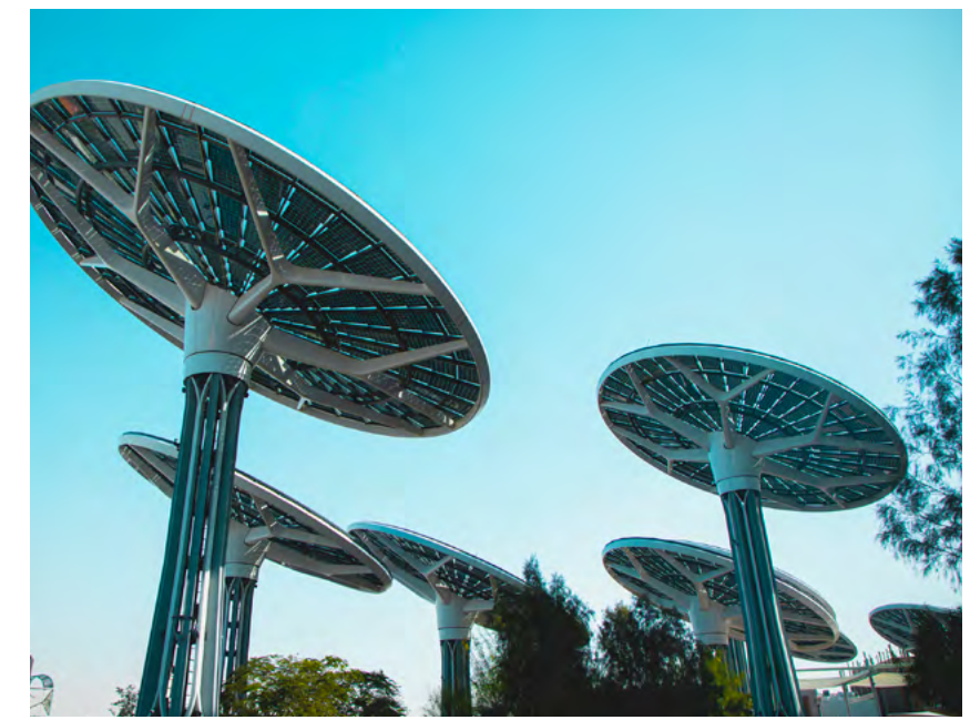
Foto: Torres captadoras de energía solar.
